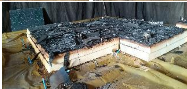
Fot. 14 Zniszczenia na wewnątrz warstwy termoizolacyjnej UKŁAD – 2 (zdjęcie autora opracowania)
