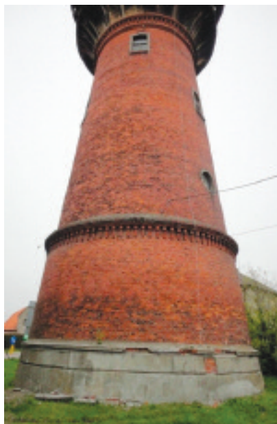
Fot. 1. Murowany trzon wieży ciśnień Photo 1. The core of brick water tower
