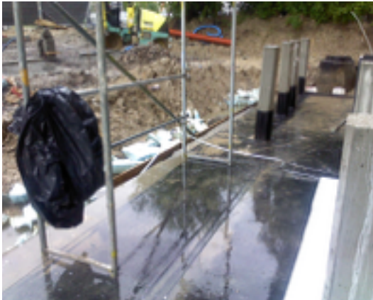
Zdjęcie 4: Montaż instalacji , po wykonaniu hydroizolacji [fot. Firma Karol Tabor]
