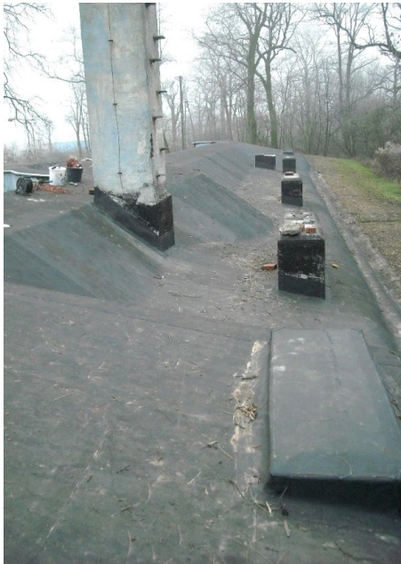
Zdjęcie 2 : Dach po naprawą – pokryty EPDM'em [fot. Firma Karol Tabor]
