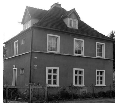
Modernizowany budynek, widok od strony północnej
