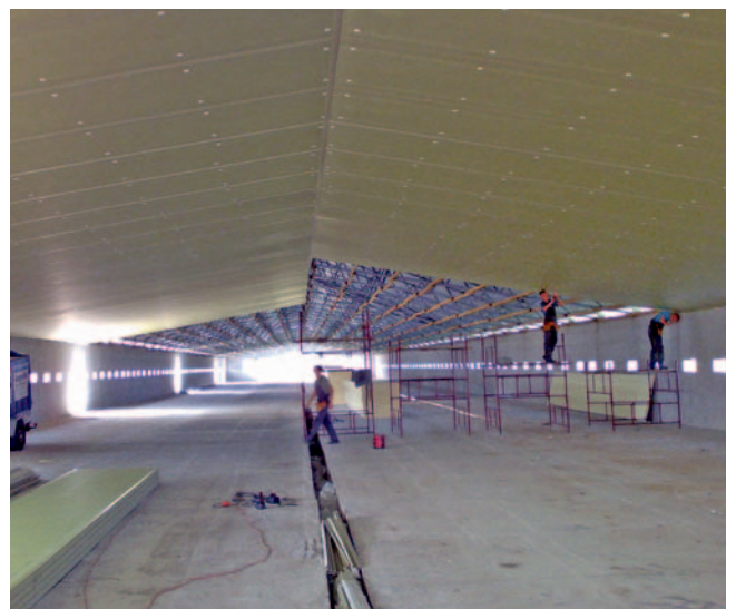
Fot. 7. Sufit wykonany z płyt izolacyjnych z rdzeniem ze sztywnej pianki poliuretanowej w okładzinach elastycznych
