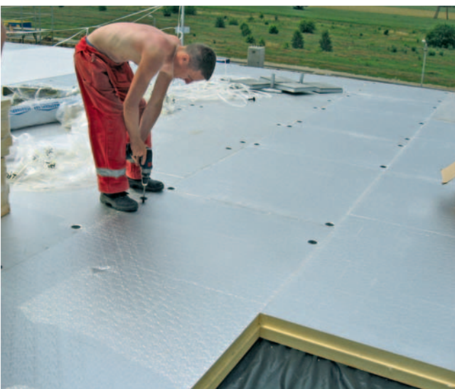
Fot. 6. Montaż płyty izolacyjnej z rdzeniem ze sztywnej pianki poliuretanowej w okładzinach elastycznych
