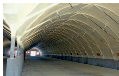
■ Fot. 2. Dach zaizolowany od strony wewnętrznej w wyniku natrysku pianki poliuretanowej
