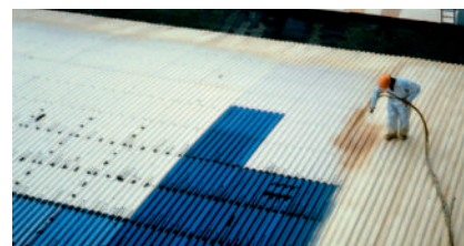
■ Fot. 3. Natrysk pianki poliuretanowej na powierzchni zewnętrznej dachu
