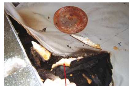
Fot. 1. Testowana próbka po zakończonym badaniu – widoczna czarna węglina na obrzeżach przelamanych płyt PIR
